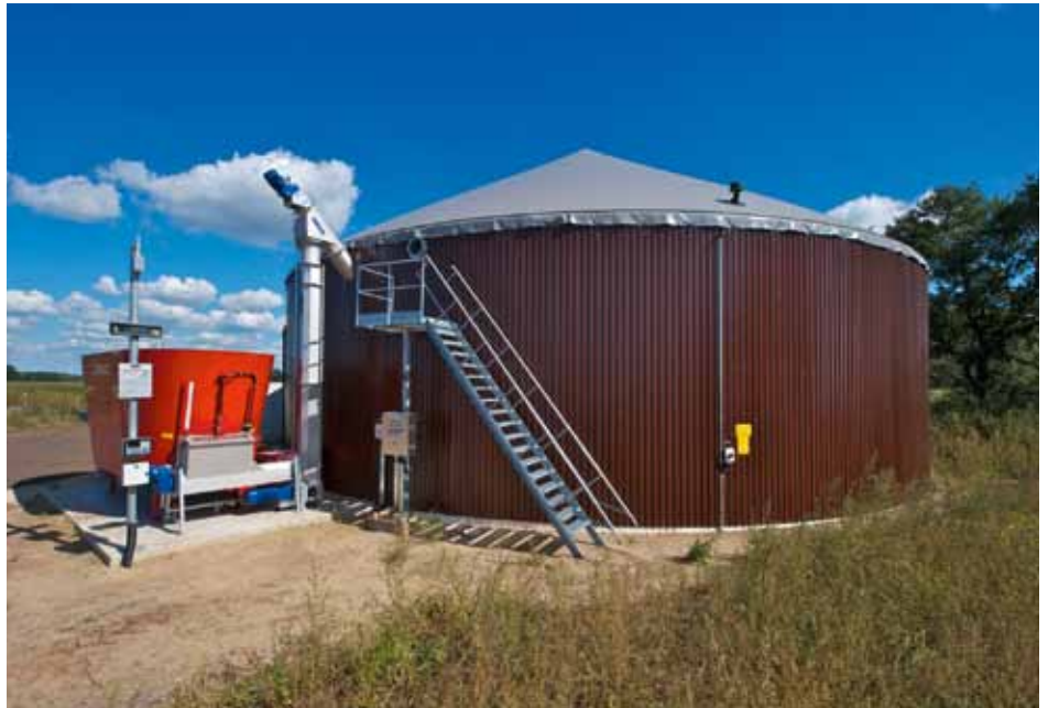
Biogasanlage in Westrittrum (bei Huntlosen).
