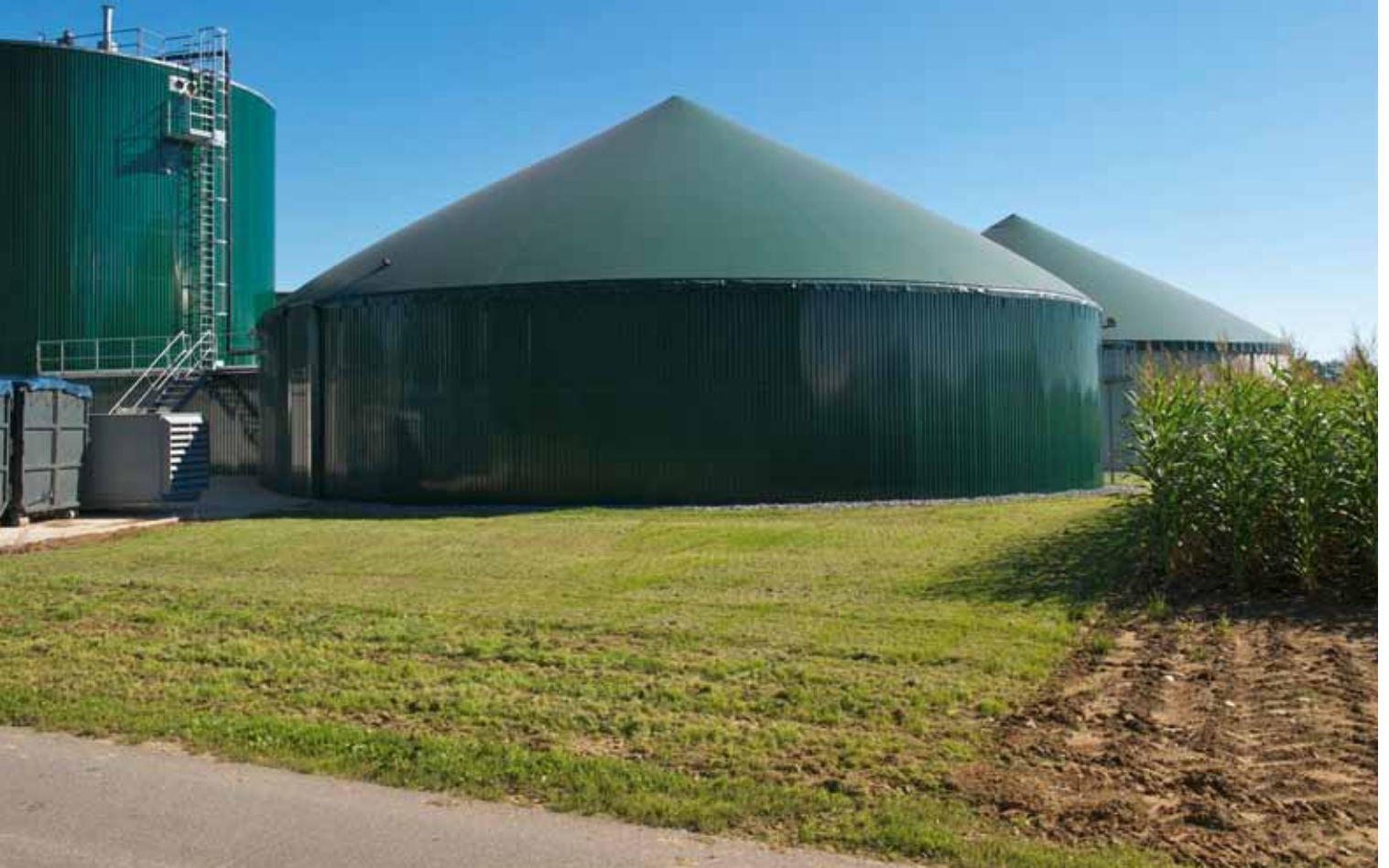
Biogasanlage in Melle. Leistung: 536 kWel; Inputstoffe: Maissilage, Hähnchenmist, CCM, Grünroggen. Wärmenutzung: Hähnchenställe, Holz Trocknung
